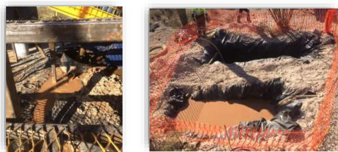
Figura 24. Agua retornando hacia la superficie y siendo dirigida hacia los cárcamos.
