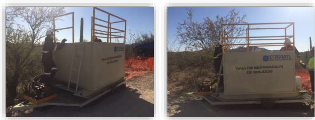
Figura 22. Prototipo instalado en área de barrenación
